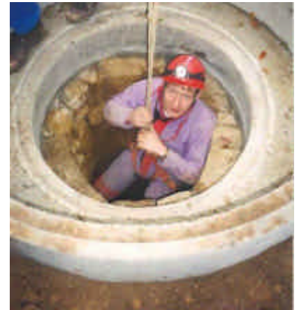
Abb.22 : Einstieg in den gemauerten Schacht -4
