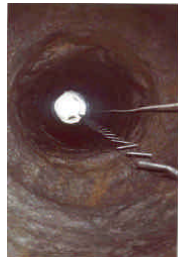
Abb. 13 Schacht 7 von unten (20 m tief)
