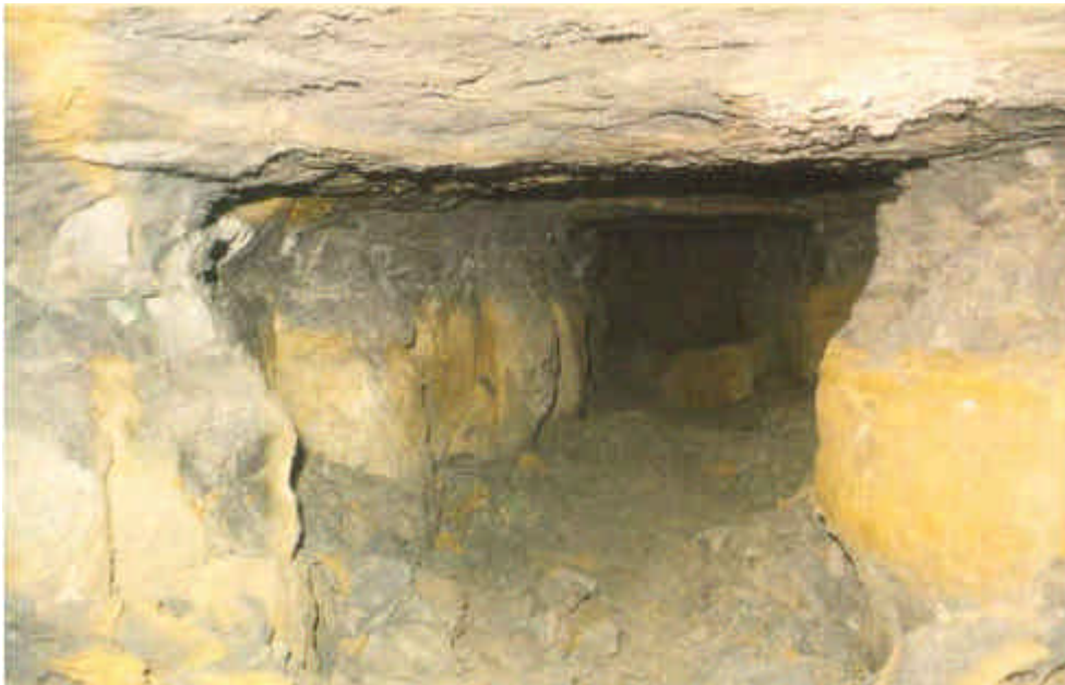
Abb. 1 : Tunnelverbindung zwischen Pütz 4 und Pütz 5
